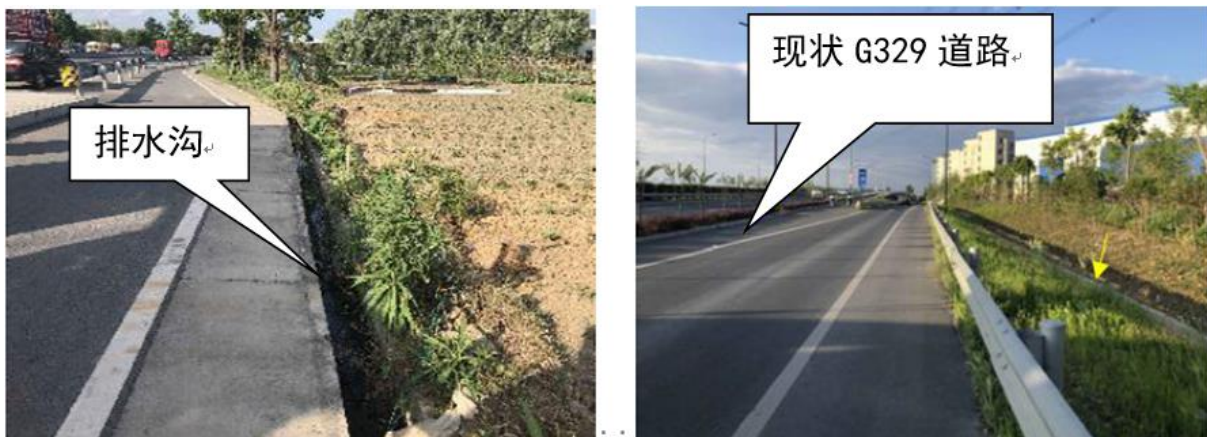
图 2.2-4 现状 329 国道防护工程、排水工程现状照片
